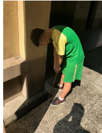
定期清理疏通水溝
