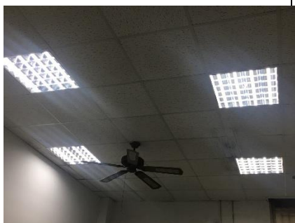
照明系統全面更新為 省電 LED 燈
